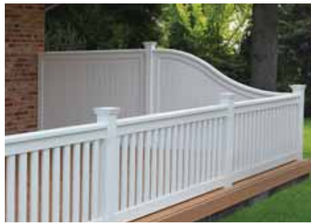
Sichtschutzwand mit Terrassengeländer.
